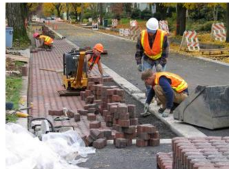
Por medio de adoquines permeables y bordillos verdes con franjas de infiltración, la ciudad de Portland (Oregon, EE.UU.) ha eliminado prácticamente la escorrentía de lluvia de las calles en zonas en donde han sido instalados.
