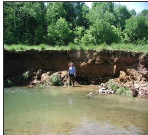
Figura 2: Los cauces de los ríos sufren graves problemas de erosión al tener que absorber repetidas crecidas de las aguas de escorrentía de zonas urbanas, causando graves daños ecológicos y económicos.
