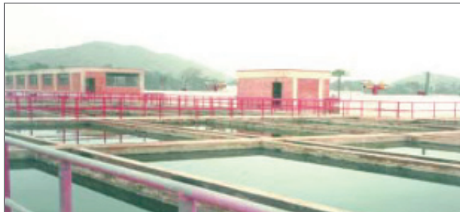
Figura 2-8. Decantador de manto de lodos (CEPIS Vargas)
