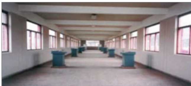
Figura 2-10. Consolas para operación de filtros.
