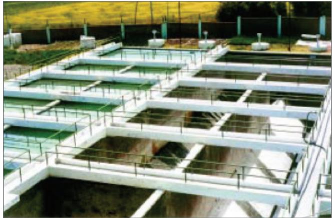
Figura 2-2 . Decantador de vuelta en U (CEPIS Vargas).
