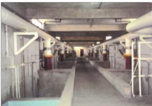
Figura 2-9. Galería de tubos de filtro de patente
