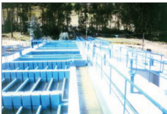
Figura 2-7. Planta de tecnología apropiada para 120 L/s
