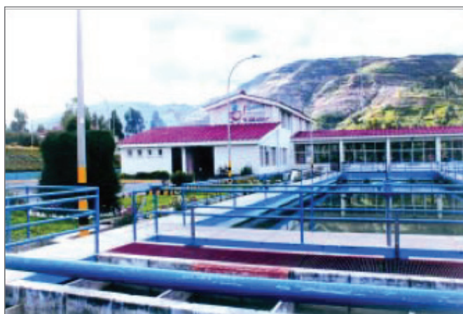
Figura 2-1. Decantador rectangular de flujo horizontal
