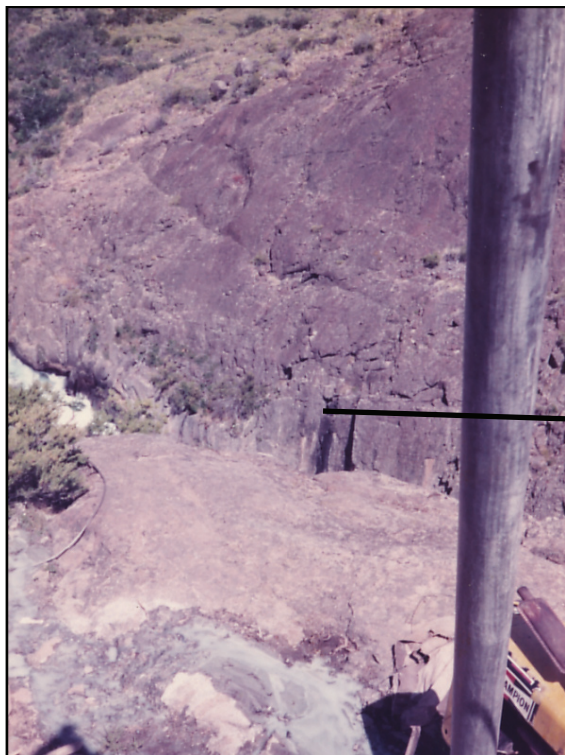
Foto N° 3 - Margen izquierdo del Río Carrenleufu, zona de empotramiento presa.
