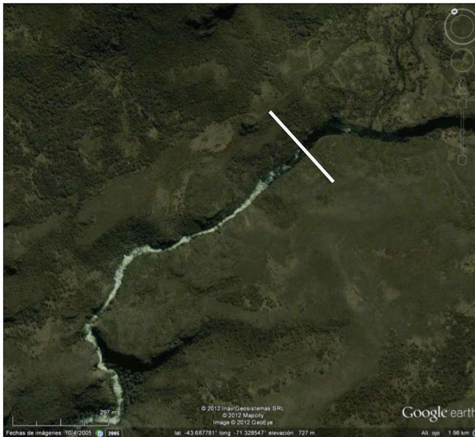
Imagen de satélite N° 1. Sitio de emplazamiento de la presa, variante A y EE.
