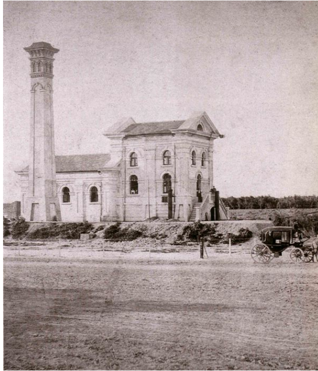
PRIMERA CASONA DE BOMBAS
