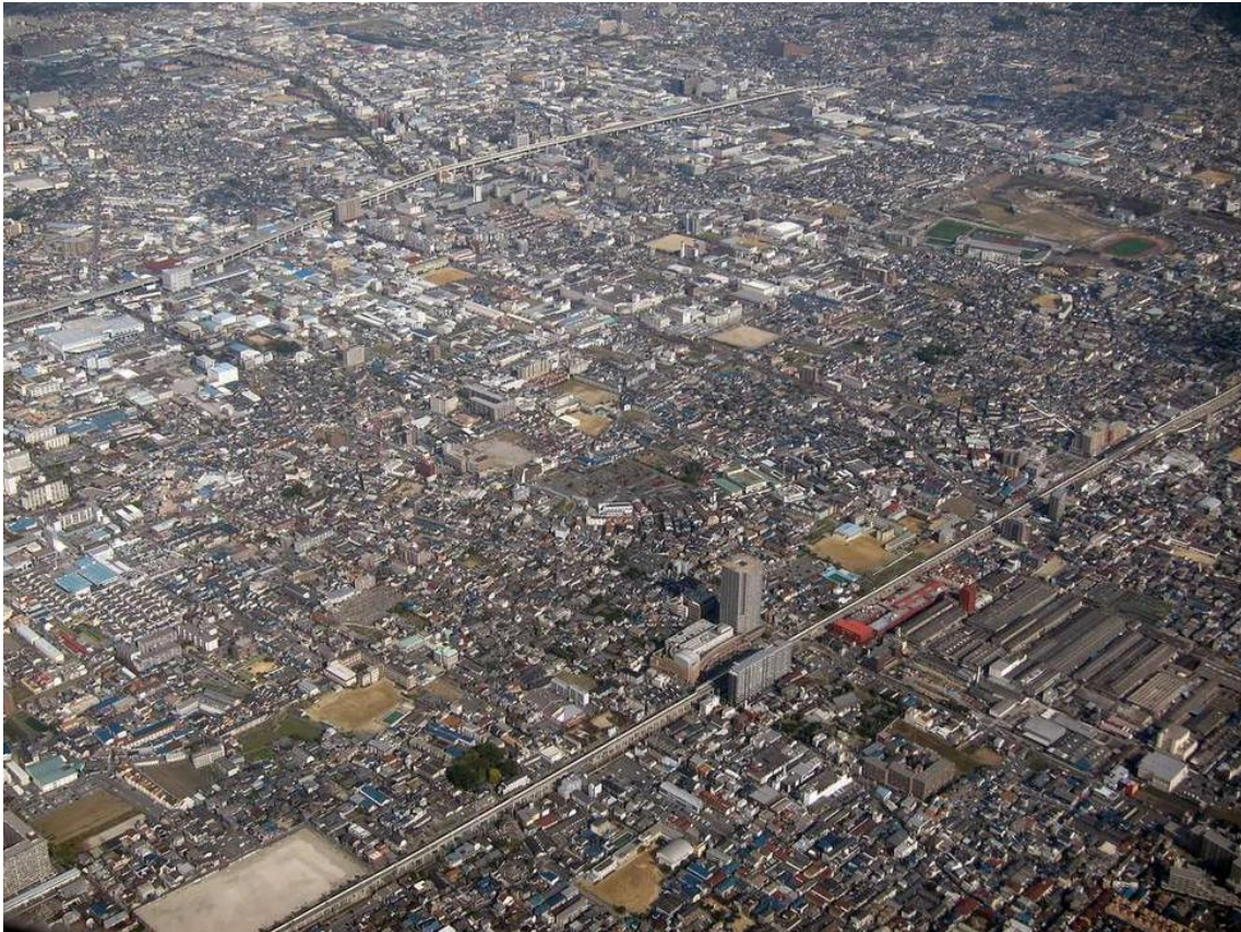
Vista aérea de los trama urbana de los suburbios de Osaka
