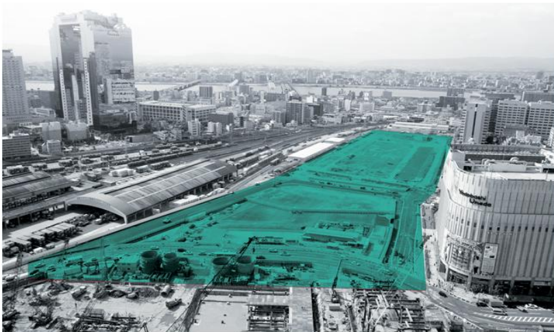
Vista panorámica de la playa de maniobras y cargas ferroviarias en la estación de Osaka (Distrito de Kita-Umeda)
