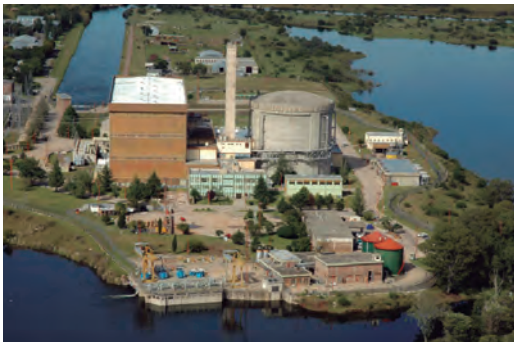
SITIO DE LA CN EMBALSE, SOBRE EL EMBALSE RIO TERCERO
