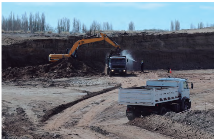
■ Figura 10: Trabajos de restitución del sitio PRAMU - Malargüe
