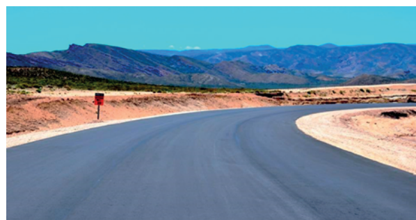
Imágen N/1: Pavimentación de la RN23 con Asfalto - Enero 2017.
