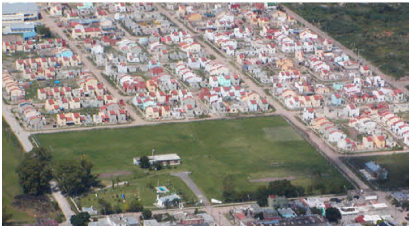
Imagen 23: Vista a vuelo de pájaro del proyecto finalizado del PROMEBA en Villa Palito-Barrio Almafuerte en La Matanza, Provincia de Buenos Aires.
