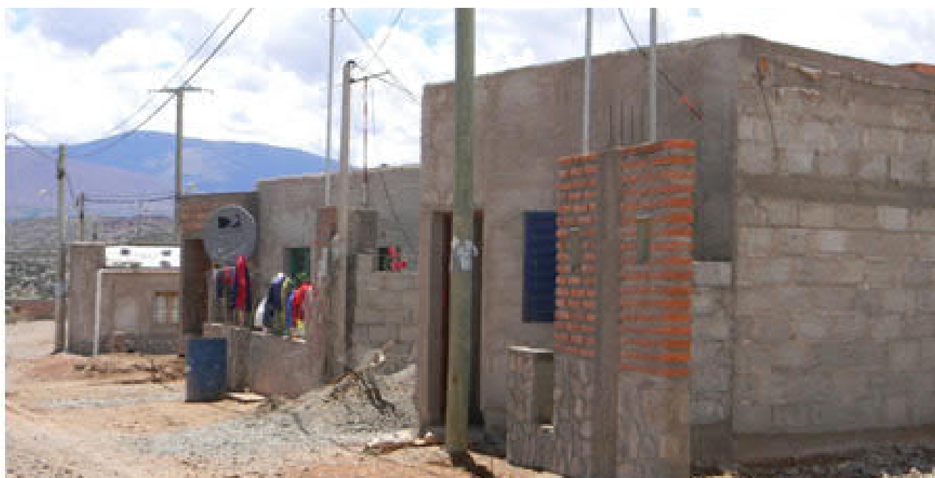
Imagen 16: vivienda recuperable, no conectada a la red de agua corriente ni cloacas. Contribuye al déficit habitacional cualitativo.
