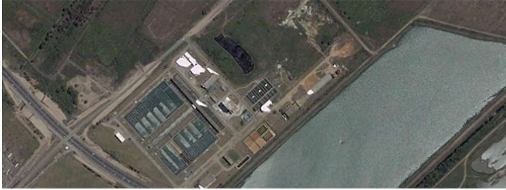
Fuente: Imagen satelital de la Planta Potabilizadora General Belgrano. Fuente: Google Earth, 2006.
