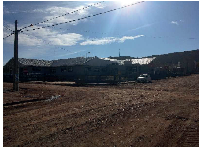
Imagen41. Hospital nuevo Añelo de nivel III
