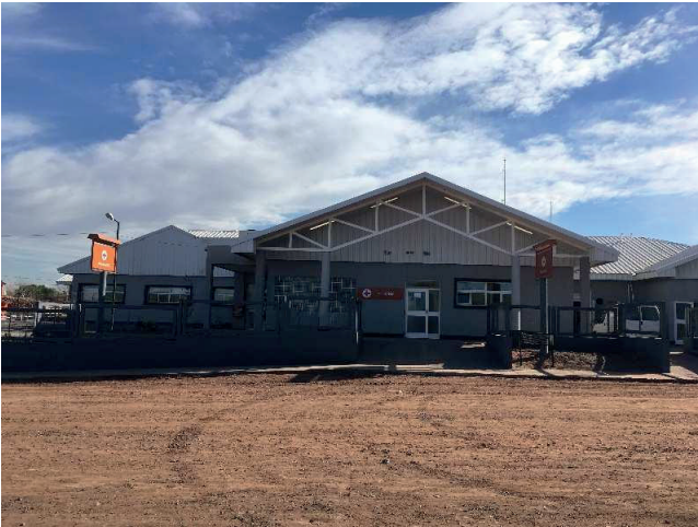
Imagen38. Hospital nuevo Añelo de nivel III
