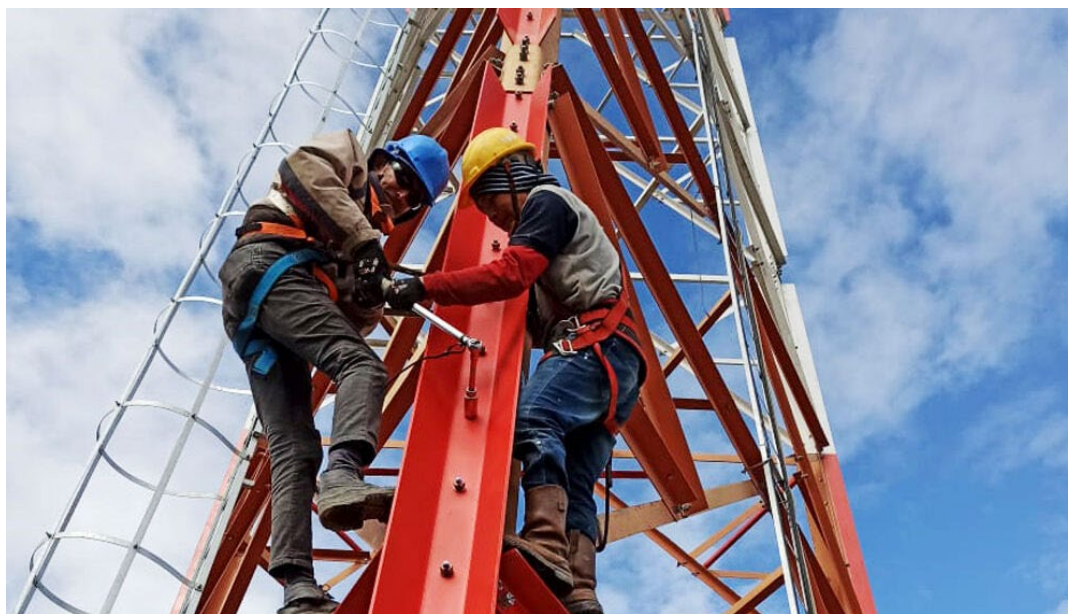
Figura.8.Mantenimiento.Preventivo.en.soporte.de.antenas; https://sedemi.com/mantenimiento_preventivo_de_estructuras_metalicas_un_eje_indispensable_para_los_servicios_de_telecomunicaciones_en_ecuador/
