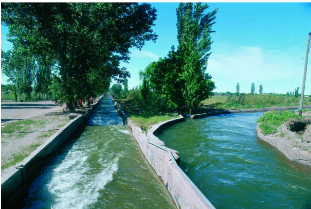
IMAGEN 10 Canales de distribución – Foto PROSAP
