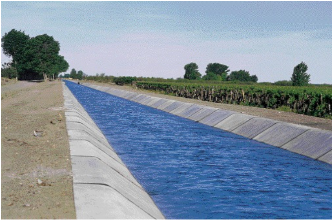
IMAGEN 9 Canal principal para riego – Foto PROSAP
