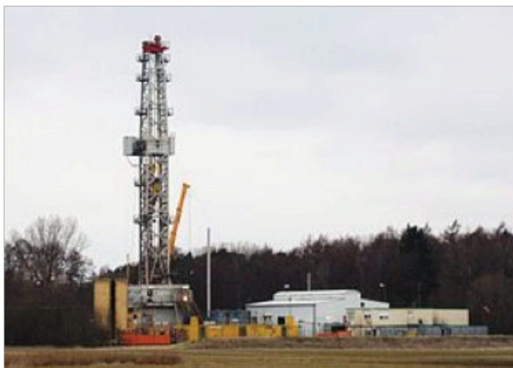
Pozo de extracción mediante fracturación hidráulica - Fuente: El abecé de los hidrocarburos en reservorios no convencionales- IAPG 2013
