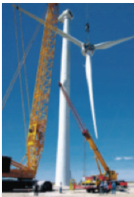
Montaje del primer generador eólico de alta potencia. Vientos de la Patagonia Fuente: Centro Regional de Energía Eólica (CREE)
